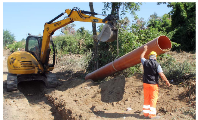
Cantiere Castelli Romani
